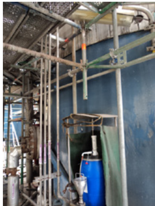
Figuur 23: Verspringing staanderinplanting
