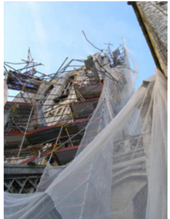
Figuur 51: Gevolg van slechte verankering
