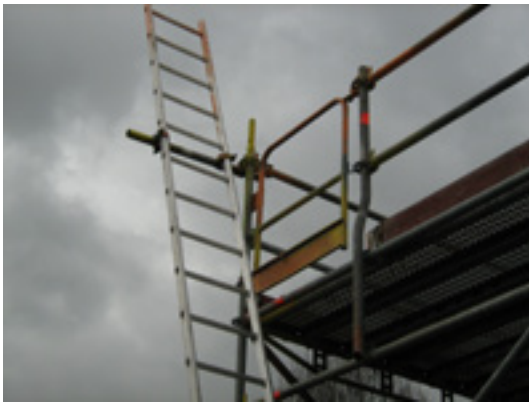
Figuur 37: Toegang via externe ladder & poortje
